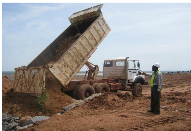
Figure n°7 : Dépôt de terre végétale sur la halde à terrils nivelée
